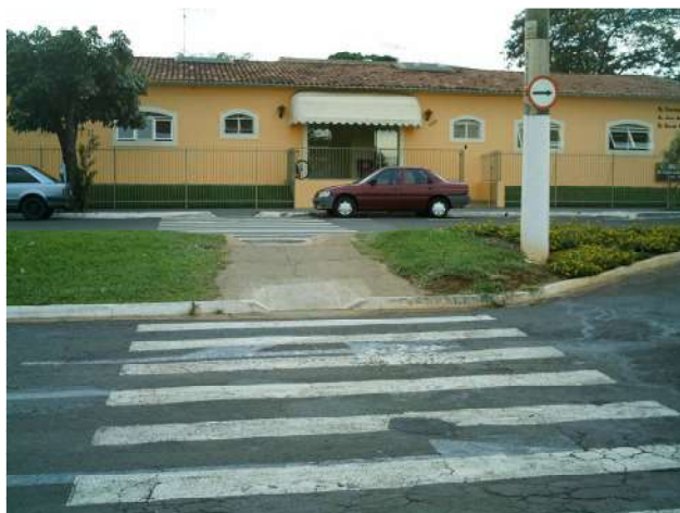
Figura 20: Travessia da Avenida Luis Saldanha Rodrigues onde apesar do asfalto irregular possui rampas de acesso, embora esta rampa pela inclinação não ofereça segurança para as pessoas com necessidades especiais.(Foto acervo do autor).
