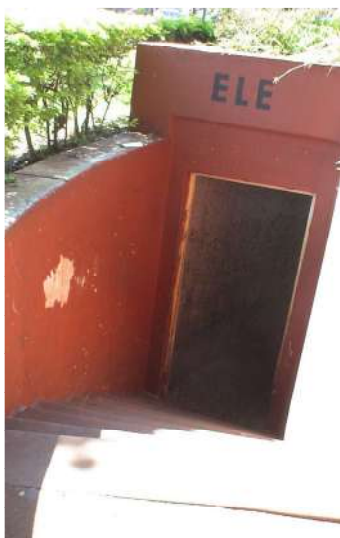
Figura 06 : entrada do banheiro masculino na praça Mello Peixoto.(Foto acervo do autor).
