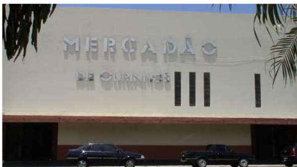
Figura 17: Foto da fachada do prédio do mercadão de Ourinhos (foto acervo do autor)
