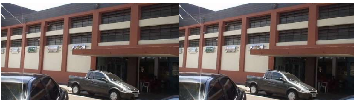
Figura 18 Fachada Lateral do Mercadão de Ourinhos (foto acervo do autor).
