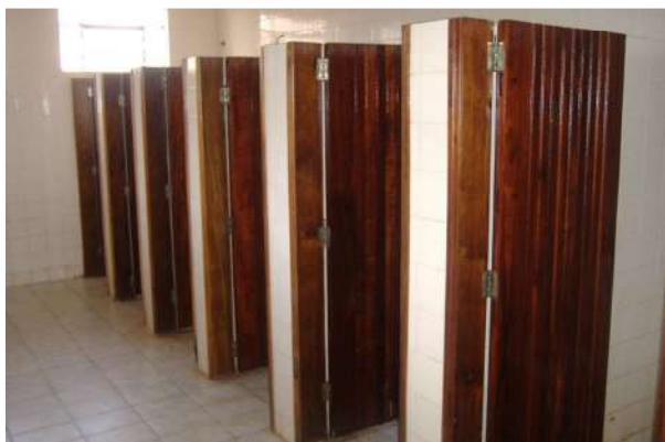
Figura 15 : vista interna do banheiro masculino do Parque Olavo Ferreira de Sá (Banheiro não adaptado) (foto acervo do autor).
