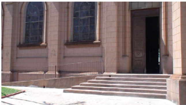
Figura 11 : entrada lateral da Igreja da Matriz com rampa para pessoas com necessidades especiais (fonte: acervo do autor)
