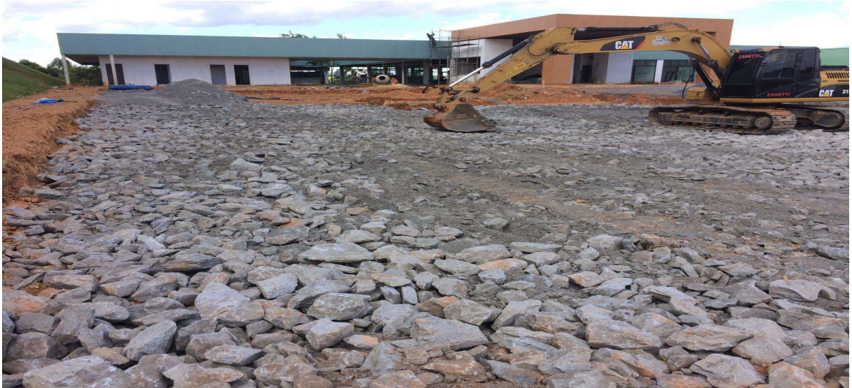
Figura 05: Ilustração de uma terraplanagem fazendo a sub-base utilizando o rachão
