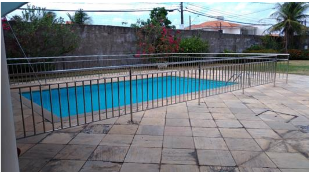
Figura 16: Piscina com guarda-corpo
