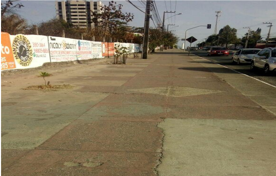
Figura 24. Calçada da Av. São Luís Rei de França 2
