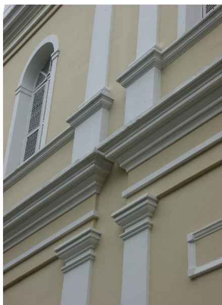
Imagem 07: Elementos estilísticos: colunas e cimbalha
