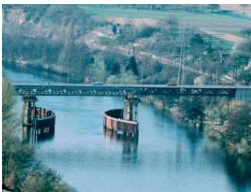
Figura 2: Ponte próxima ao rio Neckar, Alemanha, durante a construção. Fonte: SVENSSON (2009).
