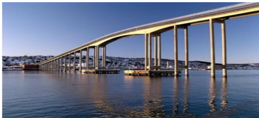
Figura 4: Ponte Tromso, Noruega. Fonte: SILVA (2016).
