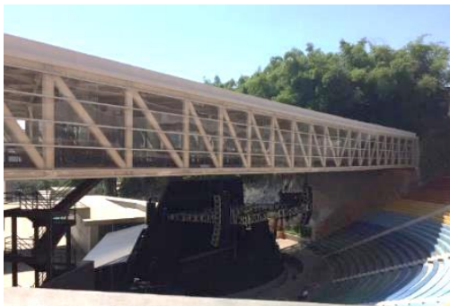
Figura 1 – Passarela técnica (atual cobertura do palco). Fonte: os autores
