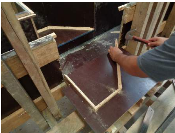
Figura 03 – Montagem consolos laterais
