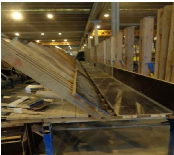
Figura 01 – Fôrma de madeira
