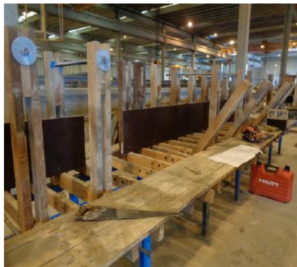
Figura 02 – Montagem laterais da fôrma
