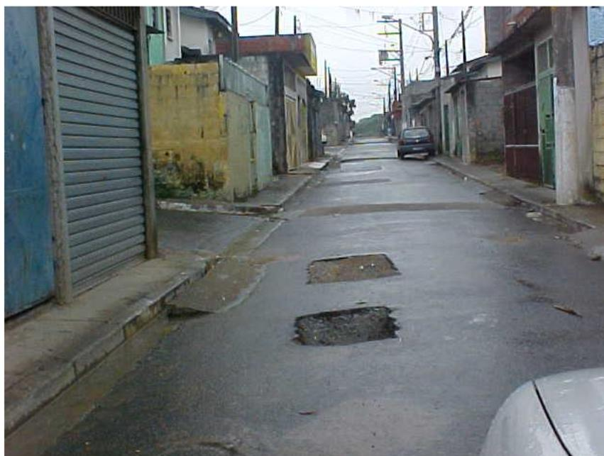
Figura 10 – Exemplo de Recorrência de Vazamentos identificada a partir dos diversos reparos notáveis no asfalto.
