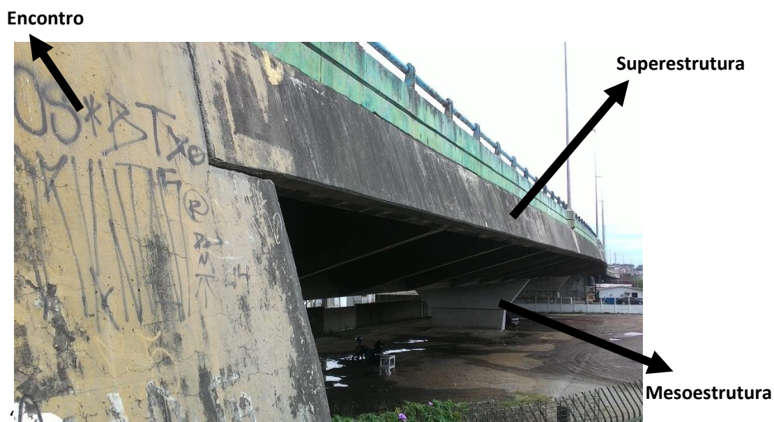
Figura 1. Viaduto na Marginal Pinheiros (Foto: Henrique Caetano, 2019).
