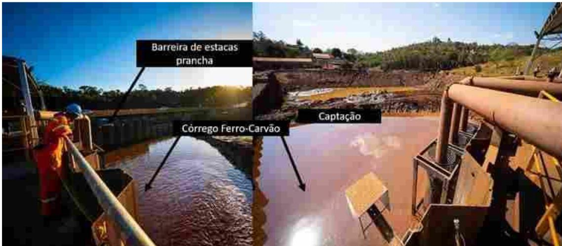
Figura 3 - Barreira de estacas prancha e captação. Fonte: Acervo fotográfico da empresa Allonda Ambiental, 2019.
